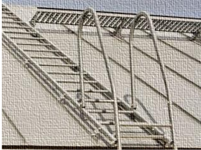
Talotikkaiden ankkurointi rakenteeseen.
