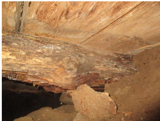
Kuva 1d. Multapenkkiperustus. Iahoa lattiankantajassa.
