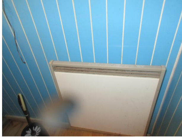
Kuva 8a. Lämmityspatteri.
