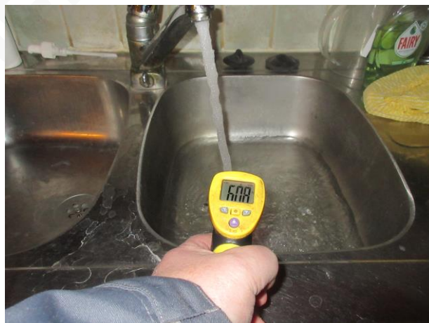
Kuva 9b. Vedenvirtaaman koestus, veden lämpötilan mittaus ja allasviemäriin tiiveyden testaus.
