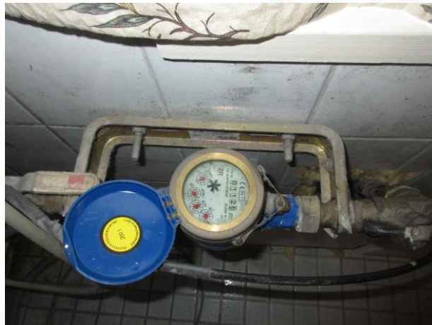
Kuva 9a. Ilmaisuhyrrä liikettä ei ollut, kun vesipisteet olivat suljettu (ei siis akuuttia vuotoa).
