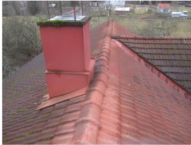
Kuva 4a. Yleiskuvaa vesikatteelta.
