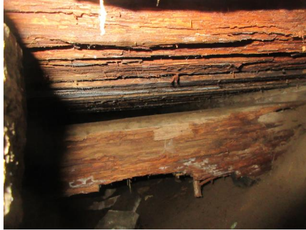
Kuva 1h. Alapohjan puumateriaalia.
