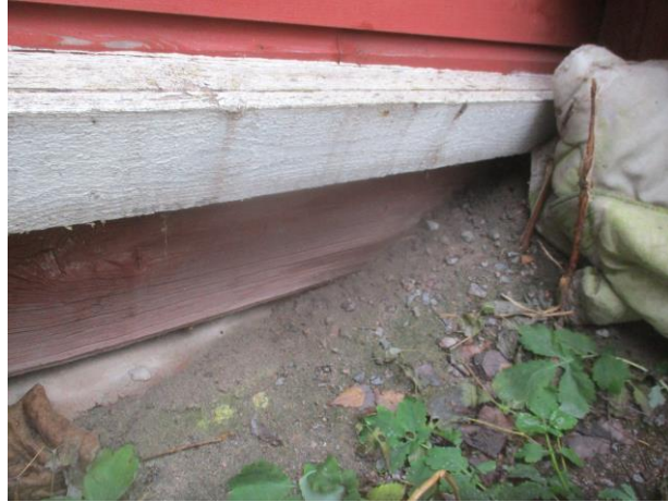
Kuva 2d. Rakenteet sorapenkaa vasten.
