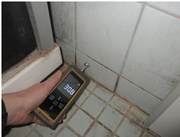
Kuva 5b. Koholla olevaa kosteutta ei havaittu.
