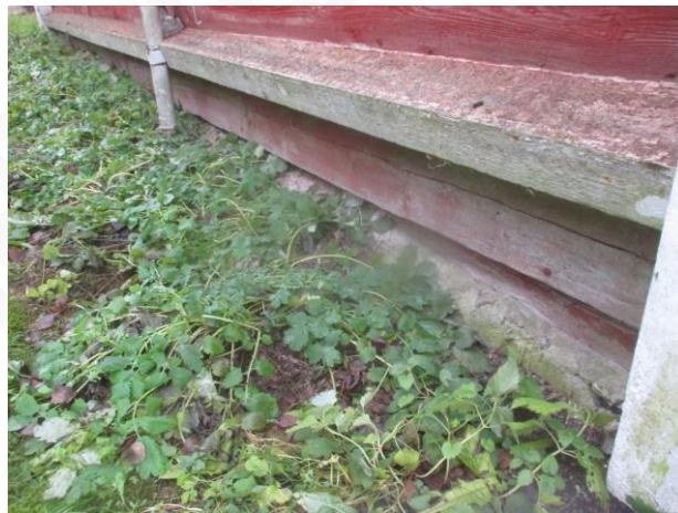
Kuva 2c. Verhouksen alaosa, joka on lähellä maanpintaa tai hieman maanpinnan alapuolellakin.
