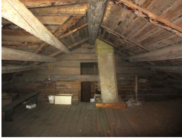
Kuva 4g. Yleiskuvaa yläpohjasta.
